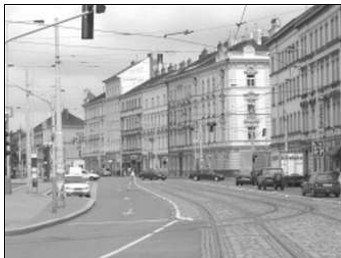
Obr. 5.8: Instalované oddělovací tvarovky pro fyzické oddělení tramvajové trati (Praha, Nádražní ulice)
