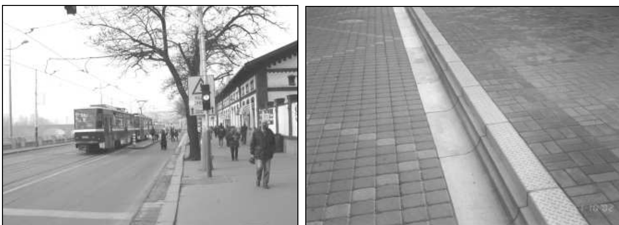
Obr. 5.16 a 5.17: „Časový ostrůvek“ se SSZ (Praha, Pražská tržnice) a tzv. Kasselský obrubník, umožňující těsné najetí autobusů a trolejbusů k zastávkové hraně
