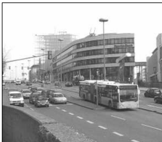
Obr. 5.2: Předsazení SZZ – umožňuje přednostní příjezd autobusům hromadné dopravy k hlavní signalizaci a jejich zařazení do příslušného jízdního pruhu před křižovatkou (snímek z Německa)
